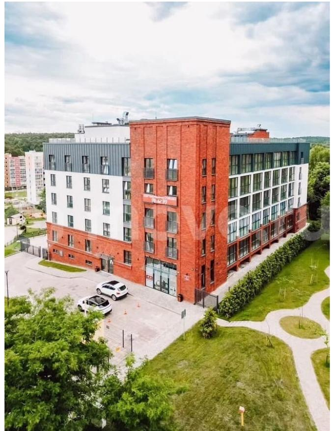
крышей; Подземный паркинг с прямым доступом к лифтам; Фасад — клинкерная плитка, декоративная штукатурка, утепление — каменная вата; Материал стен — керамические блоки; Толщина перегородок — 100 мм; Толщина внутренних стен — 250 мм; Толщина наружных стен — 380 мм; Высота потолков — 2,7 м; Подготовка под кондиционирование (останется только установить блок на крышу и в апартамент) Система видеонаблюдения; 2 современных лифта; Отопление — собственная газовая котельная
